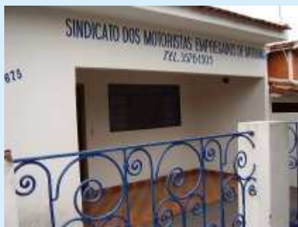
Fachada do prédio da sub sede de Ariranha
